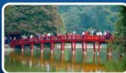
สะพานแสงอาทิตย์
